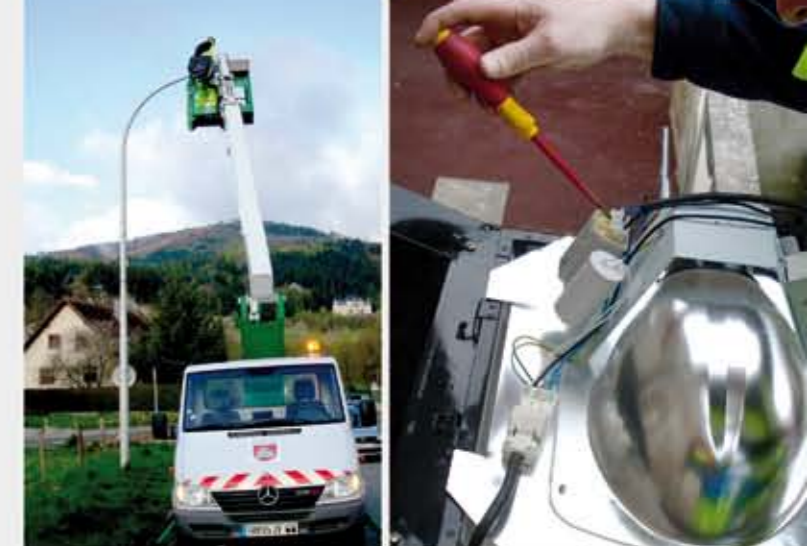
La mise en place et l'entretien des candélabres.
