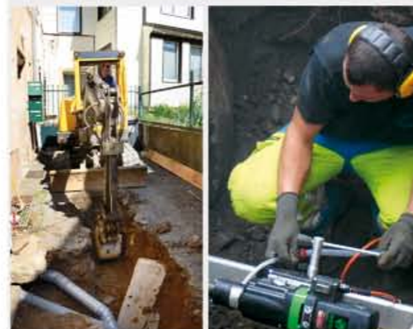
Les travaux de branchement eau et assainissement, la réparation de fuites.
